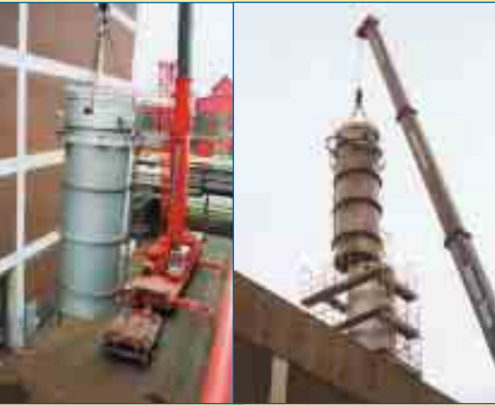
Der riesige Auslegekran packt sich zunächst die Spitze des alten Kamins in 50 Metern Höhe
