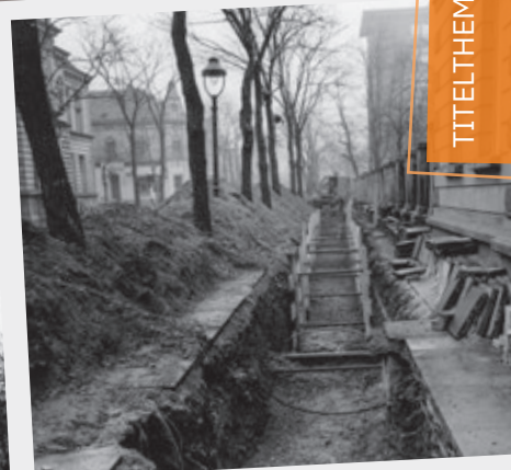
Bau einer Fernheizleitung in der Elsa-Brändström-Straße, 1958
